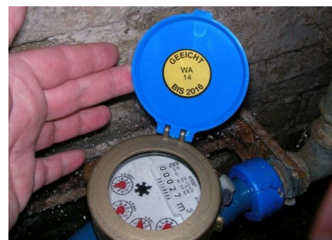
Die Wasseruhr auf diesem Bild war bis zum Jahr 2016 geeicht. Erkennbar am runden Aufkleber und der Info: „geeicht bis“
